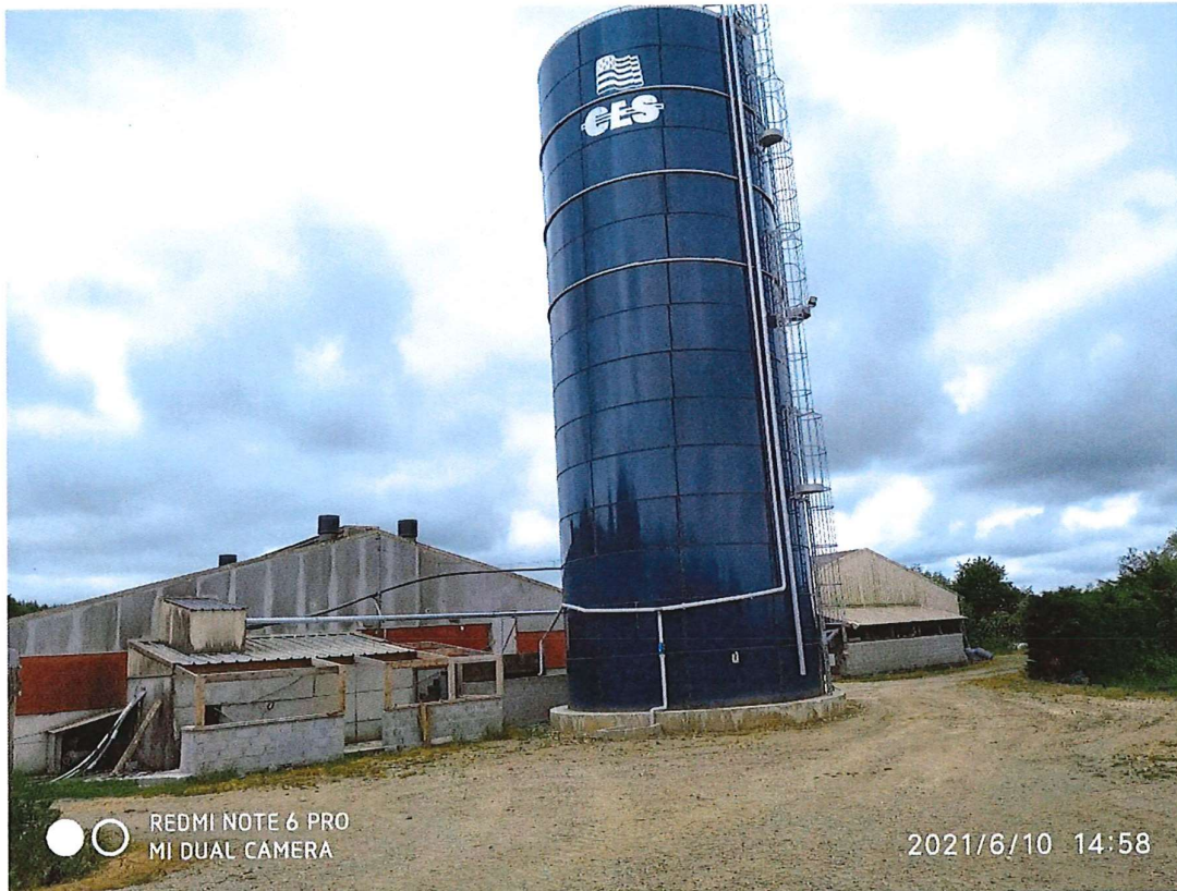
Photographie 15 : Silo tour
