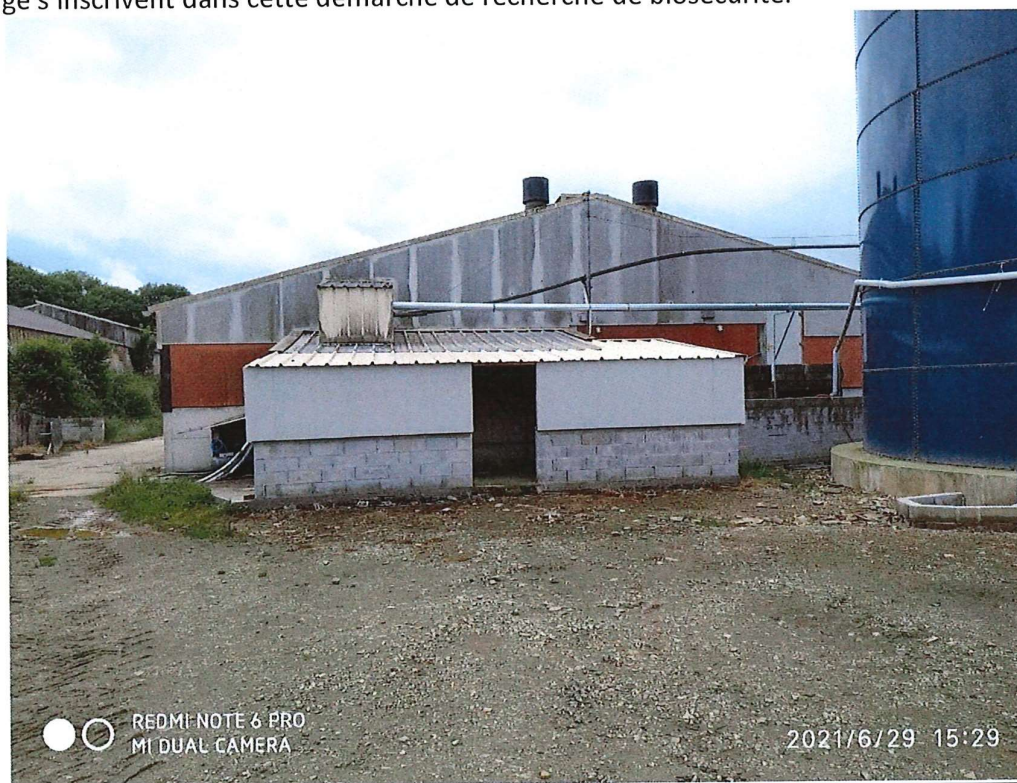
Photographie 16 : Nouveau sas sanitaire sur le bâtiment d'engraissement P1
